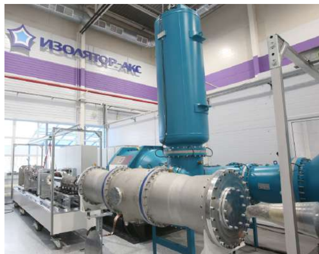
Лаборатория для приемо-сдаточных испытаний кабельной арматуры
