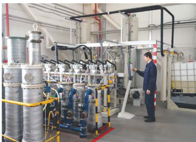
Рис. 9. Машина Hubers для вакуумной пропитки изоляции на заводе «Изолятор»
