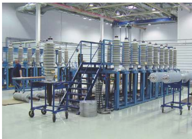
Рис. 11. Участок сборки вводов 35-150 кВ на заводе «Изолятор»
