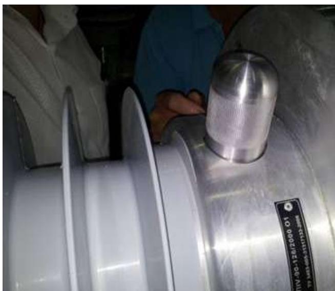
Рис.13в. Измерительный вывод с установленным колпаком
