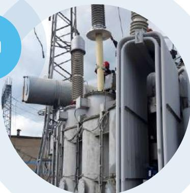
Во Владимирской области произведен монтаж первого в России ввода класса напряжения 220 кВ с твердой внутренней RIN-изоляцией для опытно промышленной эксплуатации.
