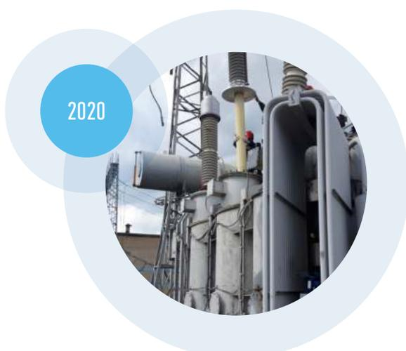
Во Владимирской области произведен монтаж первого в России ввода класса напряжения 220 кВ с твердой внутренней RIN-изоляцией для опытно промышленной эксплуатации.
