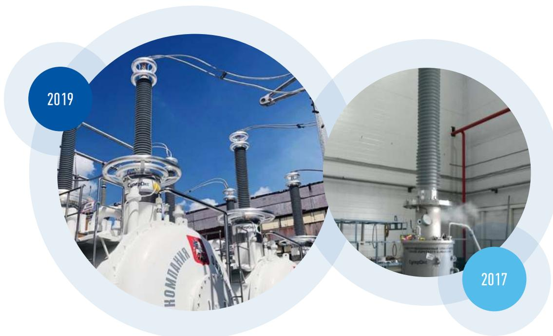
Впервые в России в Производственном комплексе «Изолятор» были успешно испытаны высоковольтные вводы, помещенные в криостат с жидким азотом. Специально разработанные вводы классов напряжения 110 и 220 кВ с RIN-изоляцией и емкостным регулированием электрического поля выдержали перепад температур от  $-200\text{ }^{\circ}\text{C}$  в нижней части до  $+10\text{ }^{\circ}\text{C}$  в верхней точке.
