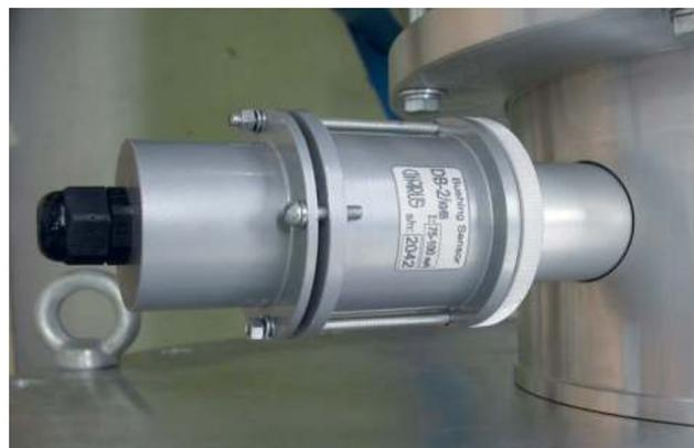
Рис.16 Датчик для защиты измерительного вывода
